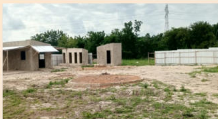
Travaux en cours dans la ville de Dimbokro
